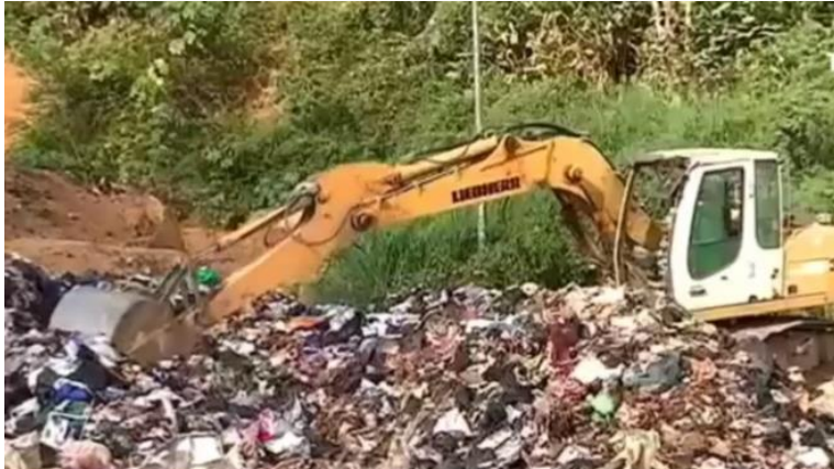
Pelleteuse sur l'ancienne décharge de Kourou (Source : Ville de Kourou)
