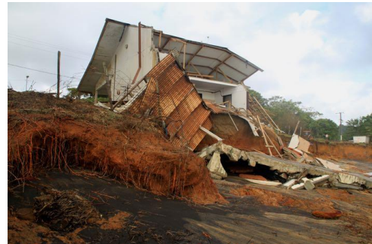
Erosion de l'anse de Rémire en 2013
