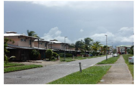
Exemple de qualification de la transition rue / espace bâti : le cheminement et les bordures bétons contiennent les espaces enherbés et assurent la continuité du parcours piéton. Un seuil incluant stationnement et plantations assure la transition entre les maisons et la rue.
